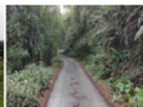
现状山体混凝土路
