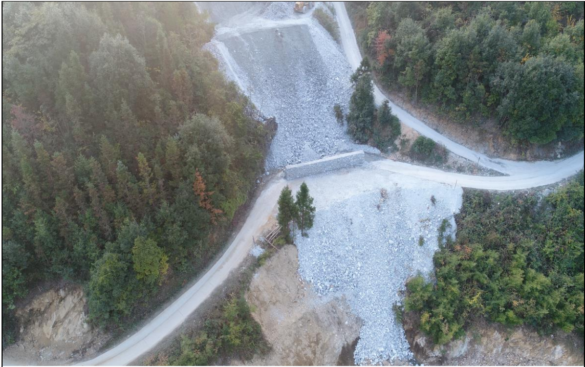
照片 9: 矿区道路拓宽路段
