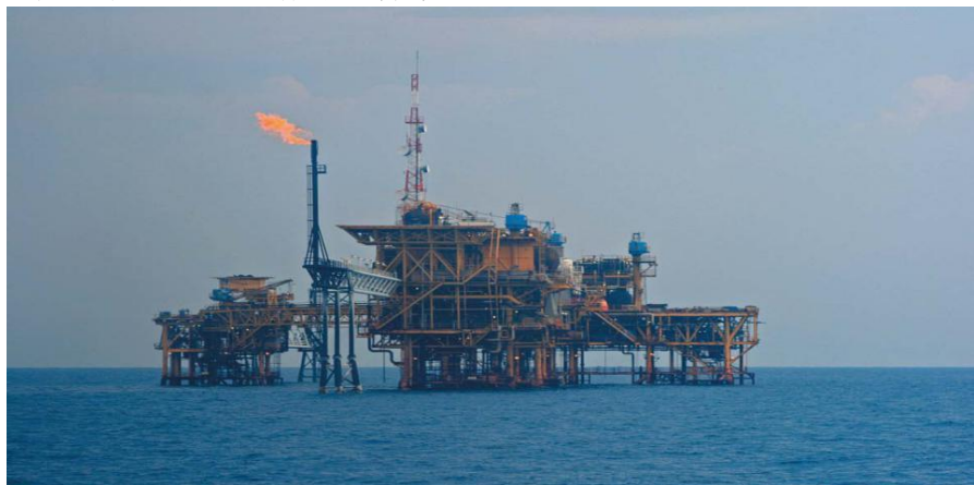
中海油在印尼的作业平台
