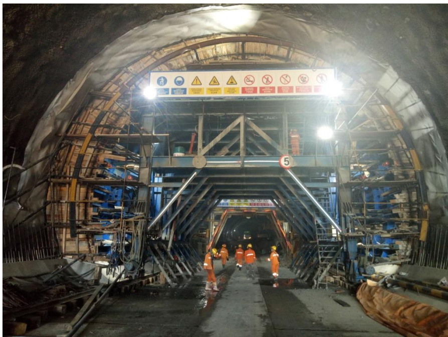
雅万高铁施工现场
