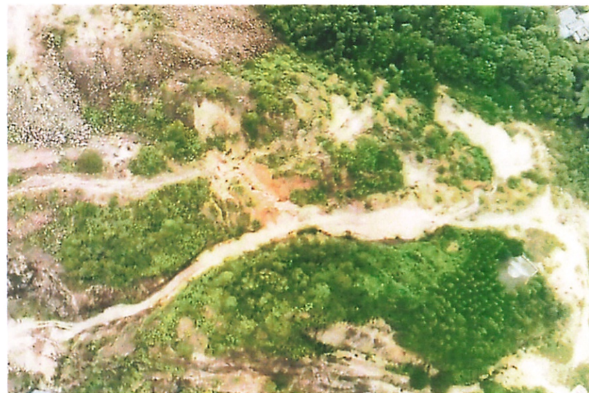
照片 3.1.3-1 矿区水土流失现状
