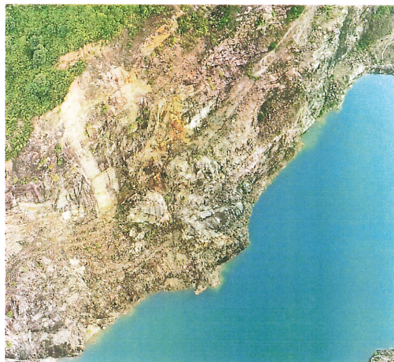
照片 3.1.1-2 东区边坡现状
