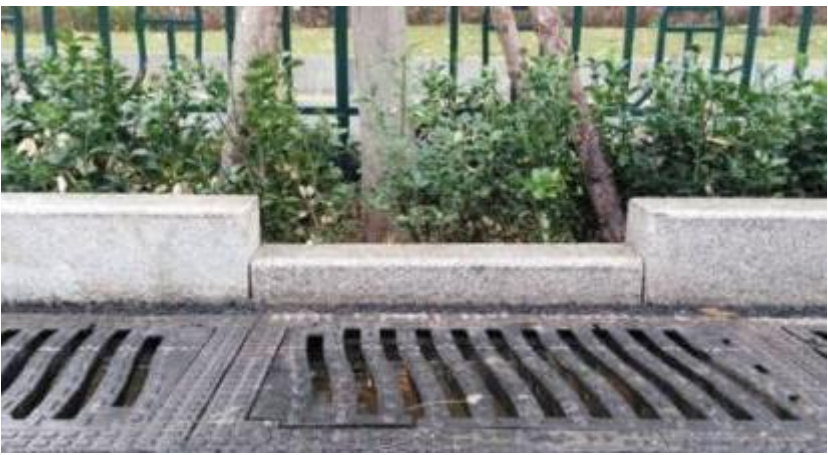
图 5-25 下沉式树池带实景图
