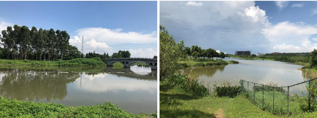
图 5-32 雨水湿地实景图
