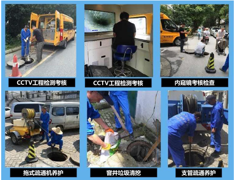
图 6-9 雨水管渠养护
