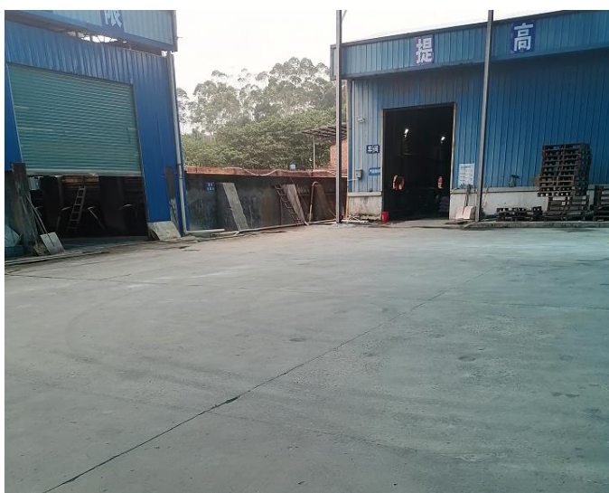
图3.2-6 单元A周围厂区内全部进行了硬底化，无表土裸露点
