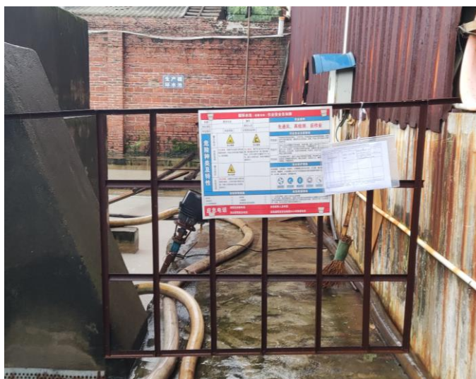
图3.2-4 循环水池通道较窄，机械进不去，另设土壤监测点
