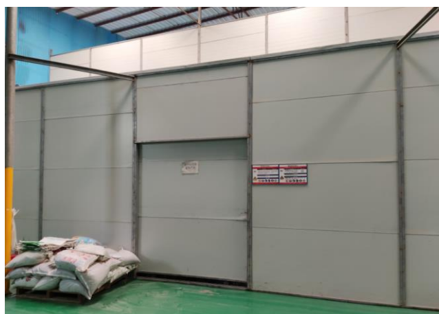
图 2.6-6 废印刷电路板生产线密闭车间
